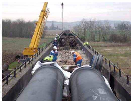
Remplacement de conduites, siphon de l'Yonne, aqueduc de la Vanne (89)
