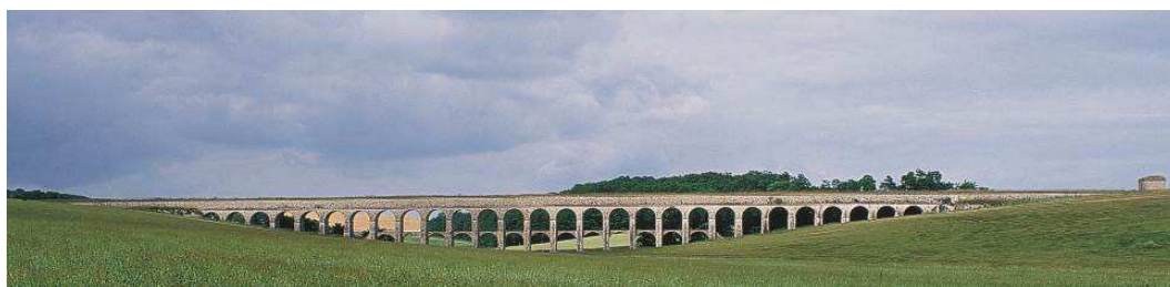
Aqueduc de la Vanne
