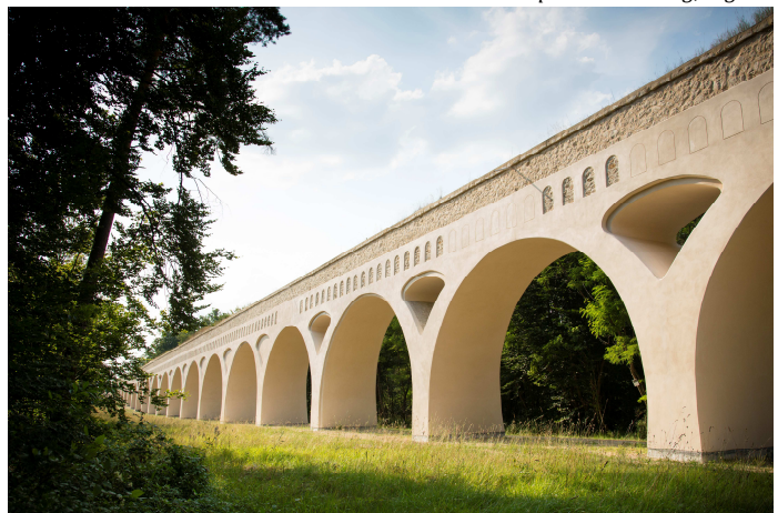
Aqueduc de la Vanne
