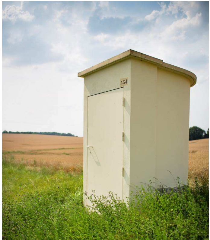
Aqueduc du Loing, regard
