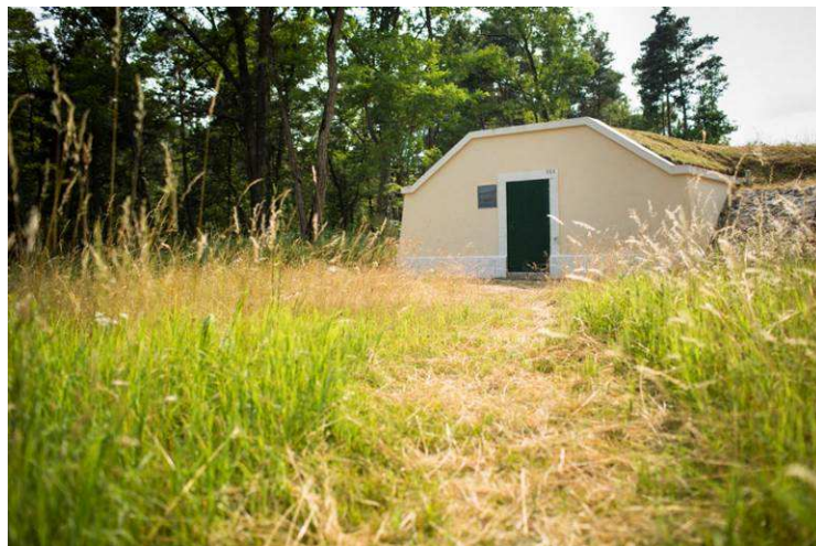
Aqueduc du Loing, tête de siphon
