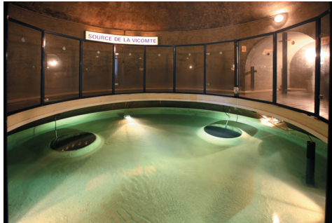
Un captage de résurgences naturelles, sans pompage Sources de la Voulzie © Gilles Targat
