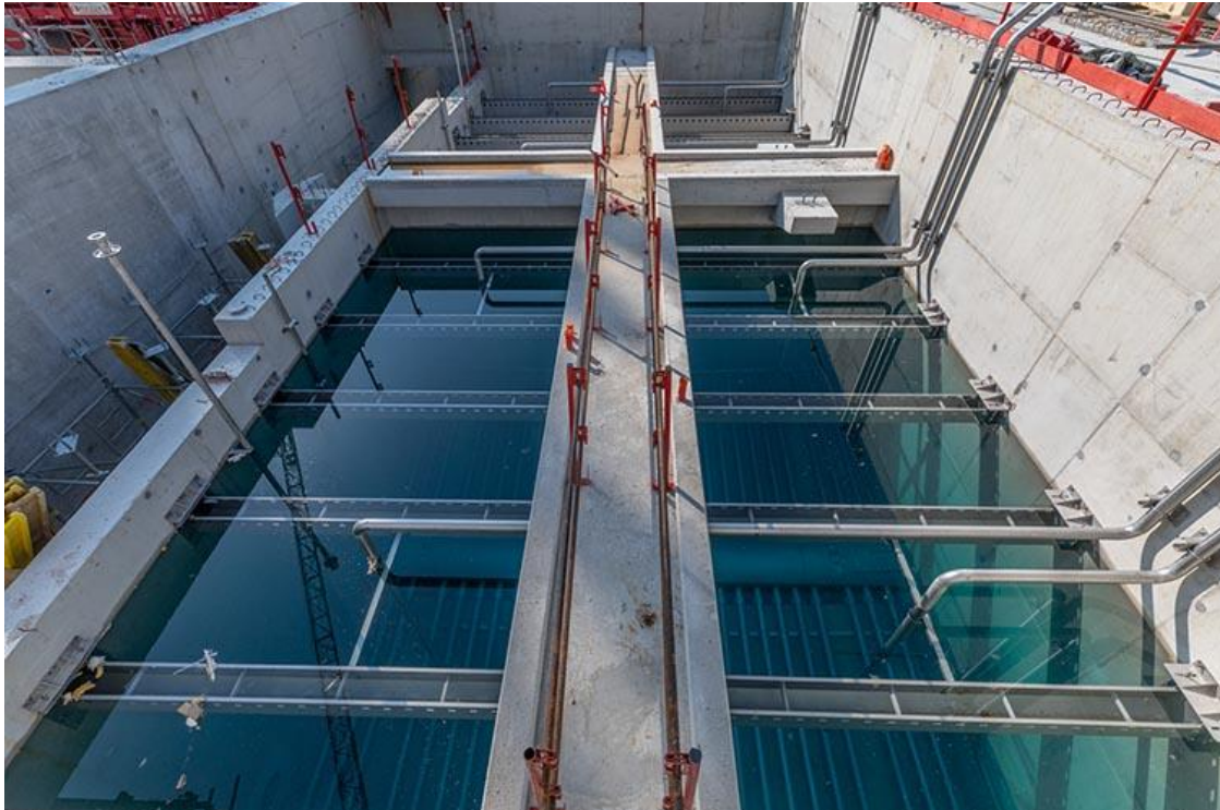
Chantier d’Orly 2. Test de l’étanchéité d’un bassin Carboplus © D. Gauducheau
