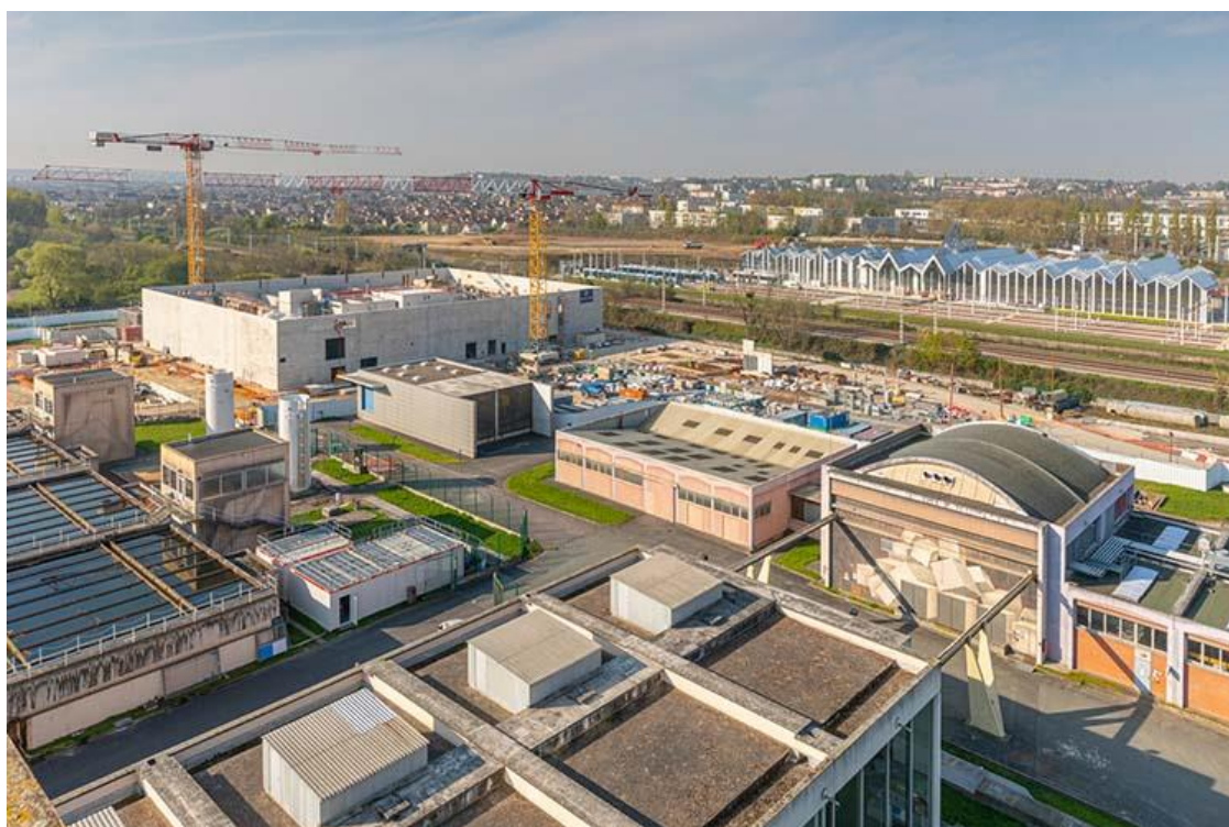
Chantier de l'usine d'Orly 2 - Avril 2021 © Didier Gauducheau
