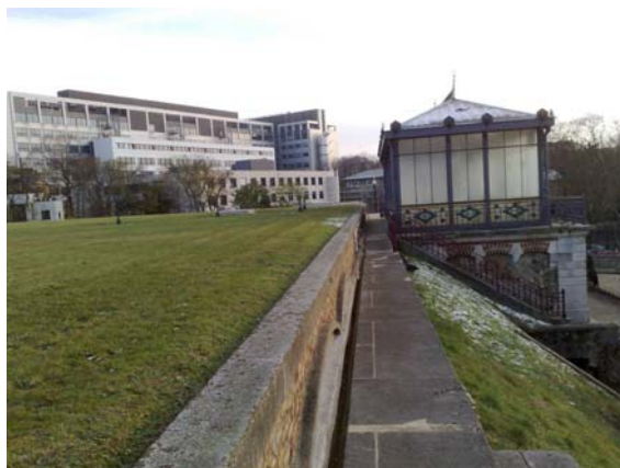
Chemin de ronde et édicule avant les travaux
