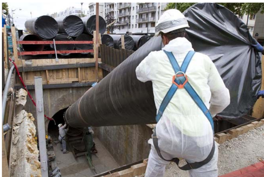
Chantier du Tramway © EAUdeParis
