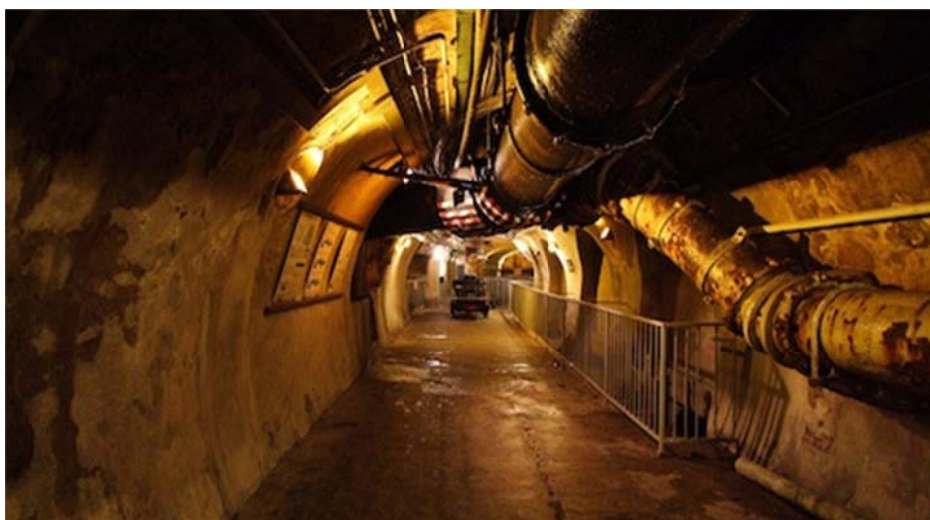
Canalisations visitables @eaudeparis
