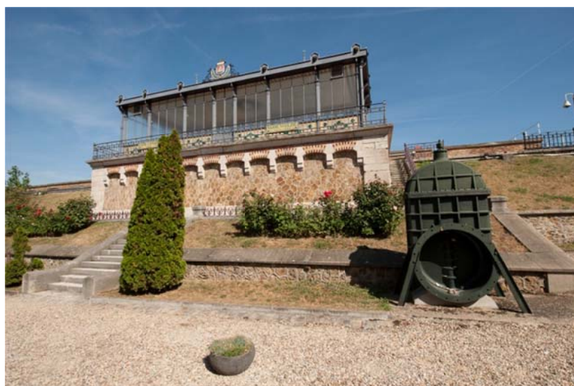
Réservoir de Montsouris ©François Grunberg – Mairie de Paris
