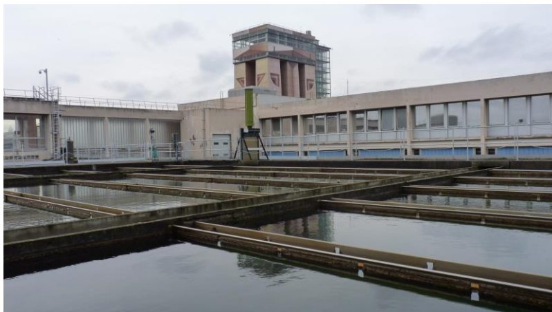
Bassins de filtration, usine d'Orly @InnerFrance
