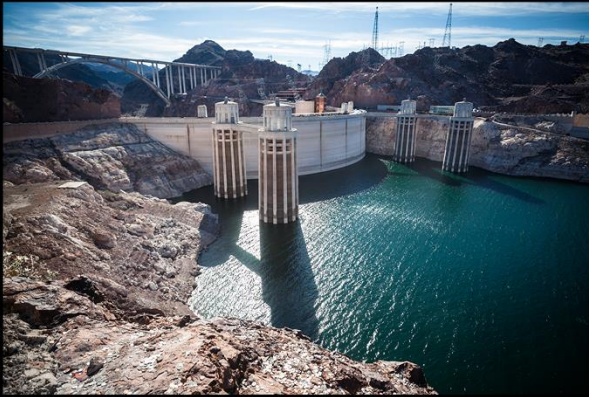
BARRAGE DE HOOVER - NEVADA
