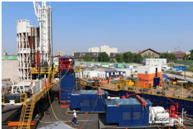
Chantier de géothermie de la ZAC Clichy-Batignolles ©EaudeParis
