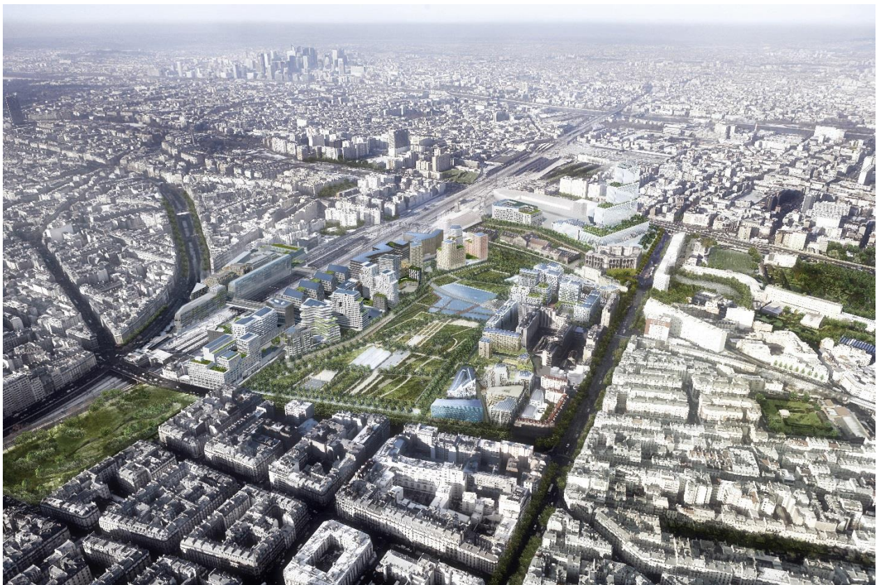
Le nouvel éco-quartier Clichy-Batignolles profite d'une chaleur produite localement grâce à la géothermie.
