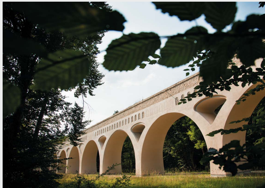
Les arcades du Grand Maître, portion de l'aqueduc de la Vienne réhabilitée en 2013 © Target
