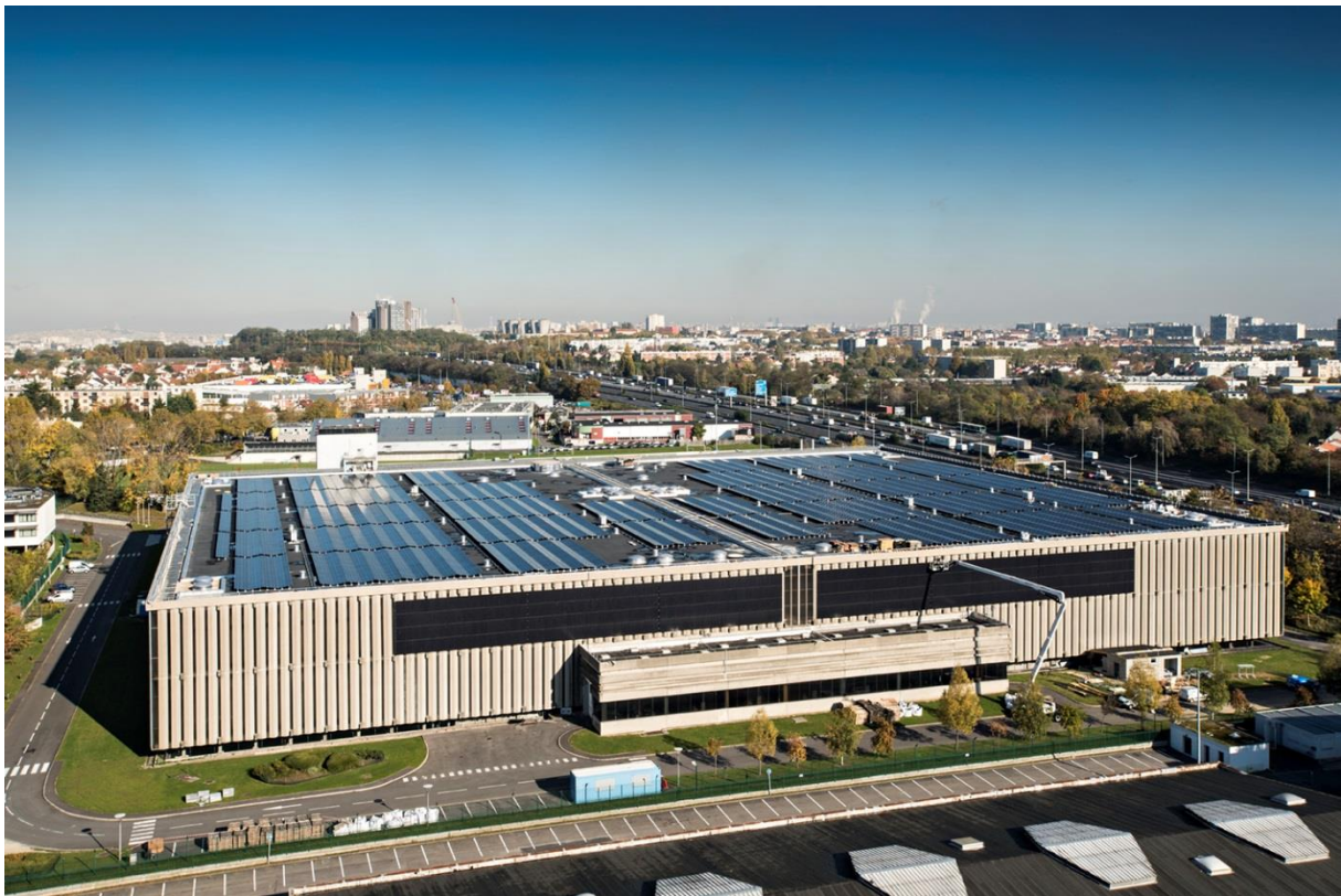
Le réservoir de L'Haÿ-les-Roses © Studio Vu pour Soprema Entreprises
