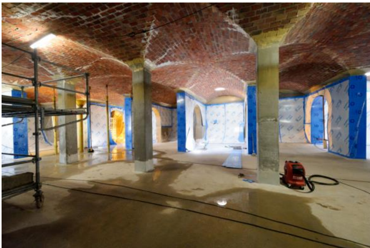
Travaux d'étanchéité dans le réservoir de Montmartre
