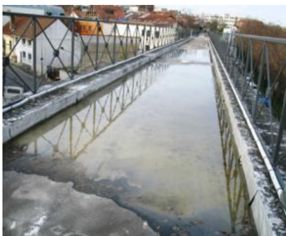
Aspect actuel de la partie supérieure du pont-aqueduc d'Arcueil
