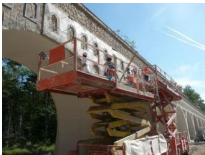
Rénovation des arcades du Grand Maître, aqueduc de la Vanne, forêt de Fontainebleau (77)
