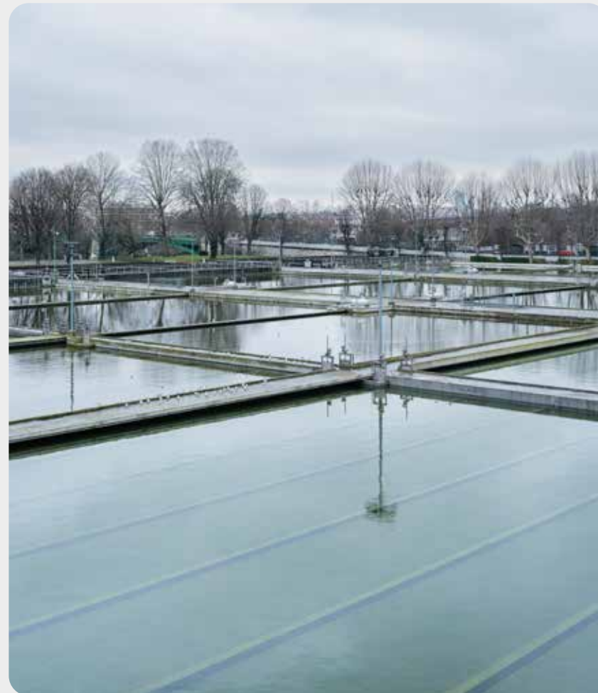
Usine de Joinville. La filtration lente consomme dix fois moins de réactifs qu'une filière classique. © Alexis Paoli
