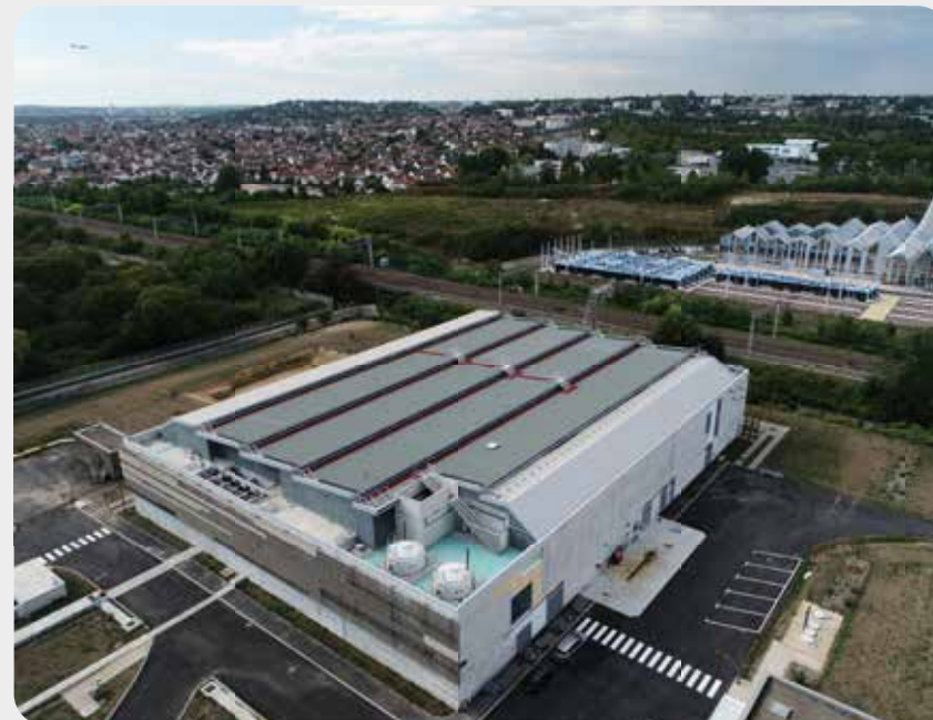
Vue extérieure de la nouvelle filière de traitement d'Orly © Stereau
